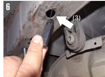
6.- Comience introduciendo primero la Solera Especial. Observe las imágenes para mejores referencias.
